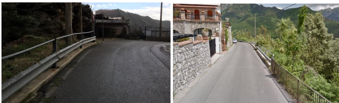
Foto di via Sambuco – A sinistra guard rail esistente, a destra tratto misto con guard rail e ringhiera ad elementi lineari
