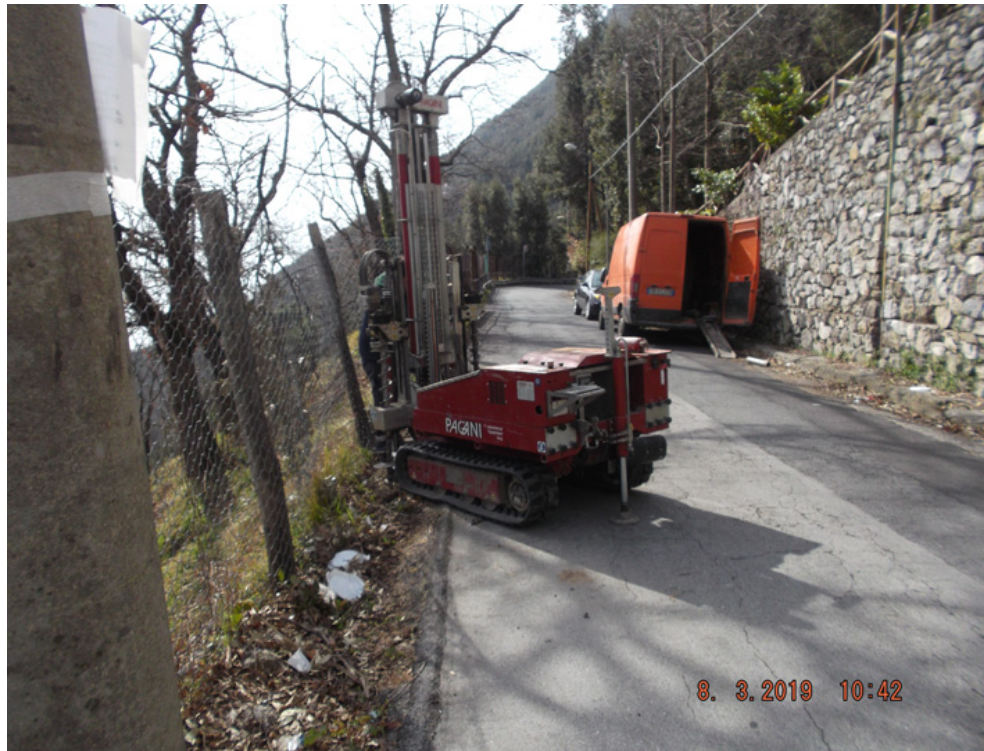
Figura 8: prova penetrometrica DPSH eseguita il 08.03.2019 sulla via comunale per Sambuco
