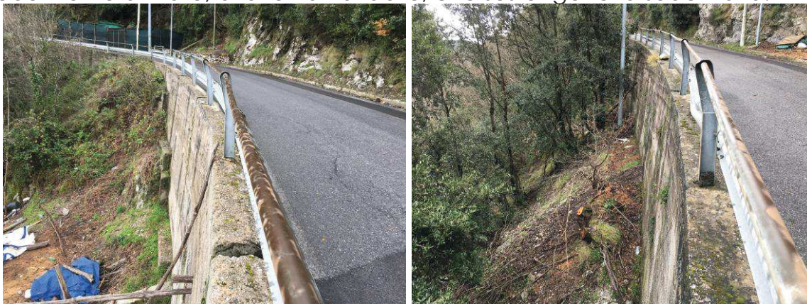
Muri esistenti in c.a., a sostegno della sede stradale
