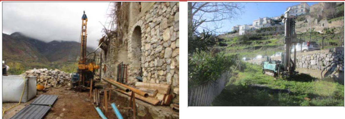
Attrezzature per l'esecuzione dei sondaggi geognostici
